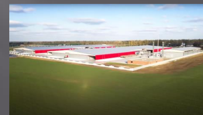
Строительство тепличного комплекса «Воронежский шампиньон», Воронежская обл.
