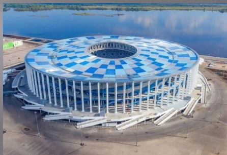
Строительство стадиона, г.Нижний Новгород
