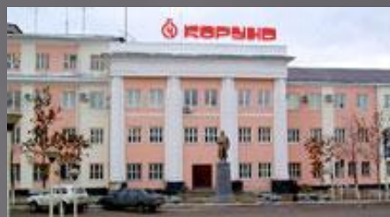
Реконструкция цеха ООО «Корунд», Нижегородская обл.
