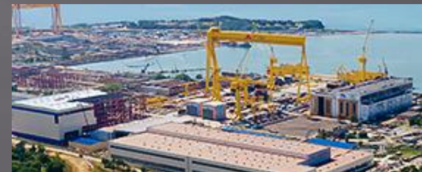
Строительство 2-х цехов и станции газификации нового комплекса АО «Дальневосточный завод «Звезда»
